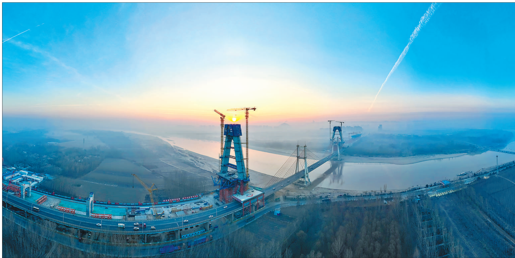
山东济南黄河公路大桥扩建工程全长7.748公里,为黄河上第一座并桥建设工程,该桥是黄河上跨径最大、钢桥总长最长的公轨分层合建桥梁。图为近日拍摄的山东济南黄河公路大桥扩建工程施工现场。
