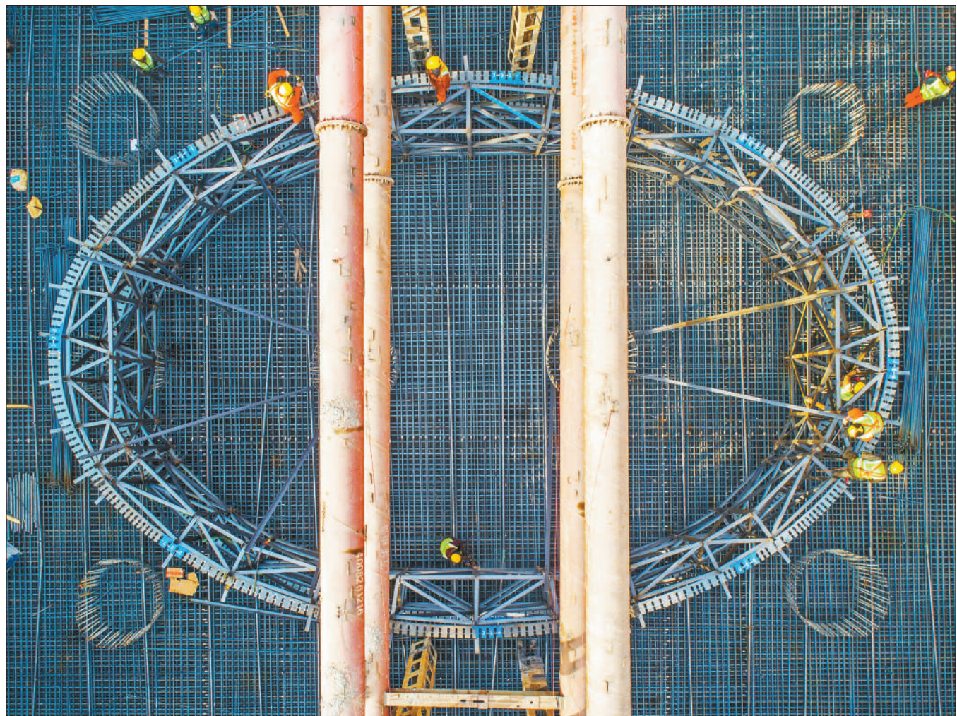
1月7日,河北省石家庄市正定县,工人在复兴大街滹沱河特大桥建设工地加紧施工。复兴大街改造项目是石家庄市更新的重点项目,全长约35.4公里,建成后将显著方便群众通行。
