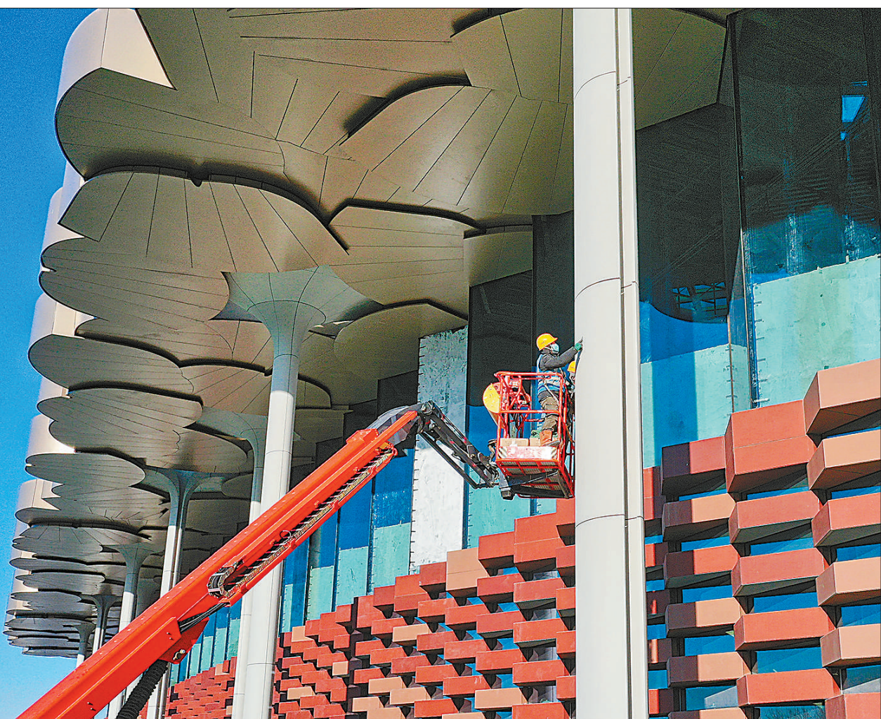
近日,中铁建工集团的工人正在北京城市副中心图书馆紧张施工。目前,北京城市副中心剧院、图书馆、博物馆等三大建筑及配套工程已进入内部精装修施工阶段,按照计划,三大建筑将于今年底全面完工并具备面向公众开放的条件。
