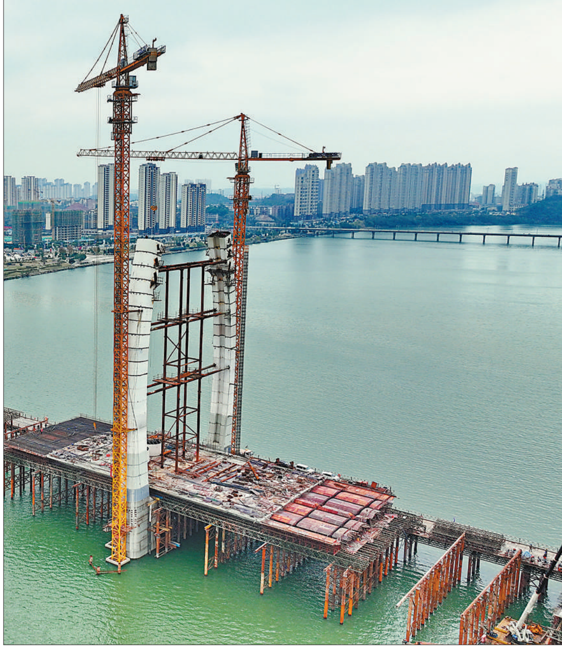
1月2日，在江西省于都县贡江上，工人在建设于都大桥桥塔并铺设桥板。据了解，于都大桥全长约960米，宽度约25.5米，双向4车道，计划今年6月投入使用，将实现于都县贡江两岸新旧城区的快速交通。
