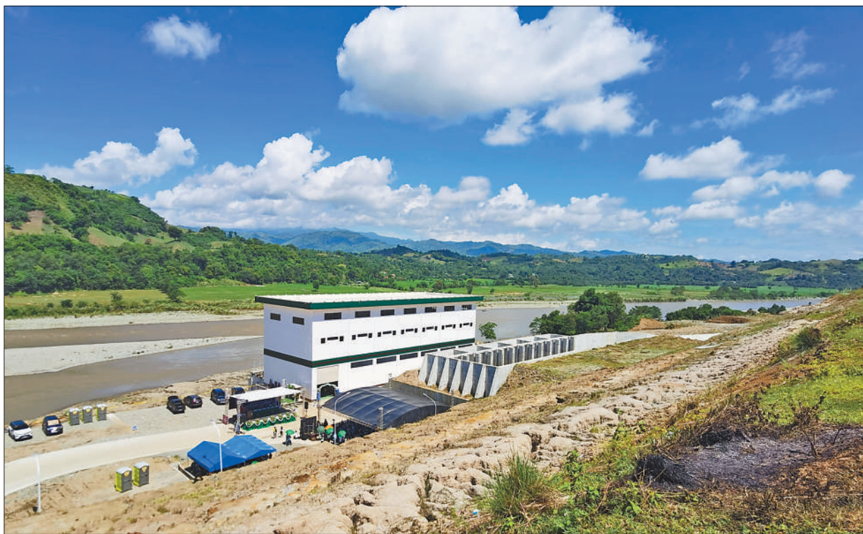
图为奇科河灌溉工程泵站。
