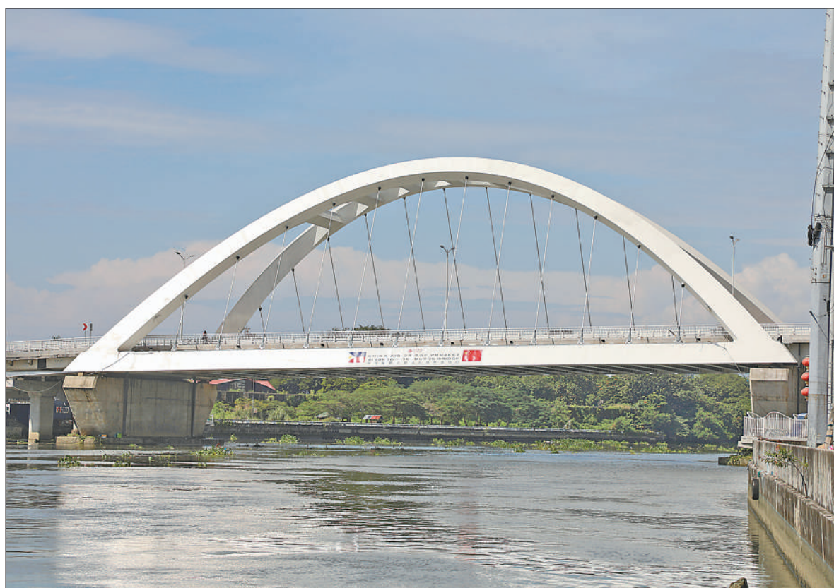
由中国政府援建的菲律宾马尼拉比诺多—因特拉穆罗斯桥横跨马尼拉城区的帕西格河，连接着两岸的历史文化街区。图为2022年10月中旬的比诺多—因特拉穆罗斯桥。
