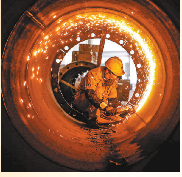
1月1日,四川省眉山市,中建钢构四川有限公司加工车间内,工人在赶制订单产品。张忠华摄(影像中国)
