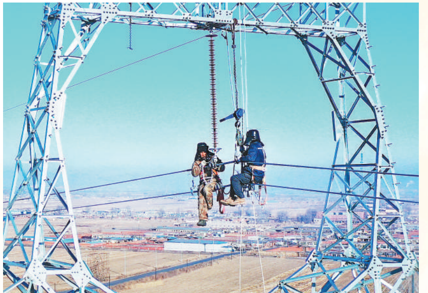
1月1日,辽宁省葫芦岛市南票区,供电公司施工人员正在进行导线架设。辛阳 王丽杨摄影报道
