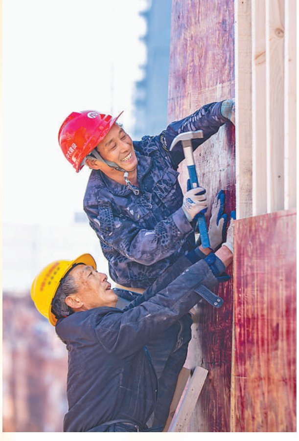
1月1日,江西省弋阳高新区标准厂房建设施工现场,工人们抢抓工期,确保项目早日建成。黄祥龙摄(人民视觉)
