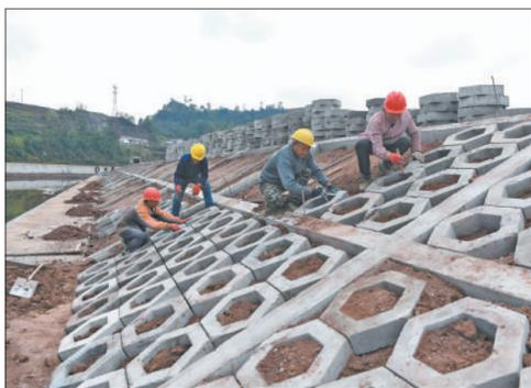
左图:在四川省广安市广安区肖溪河恒升镇代龙滩段防洪治理工程现场,工人在护坡网格内作业。
