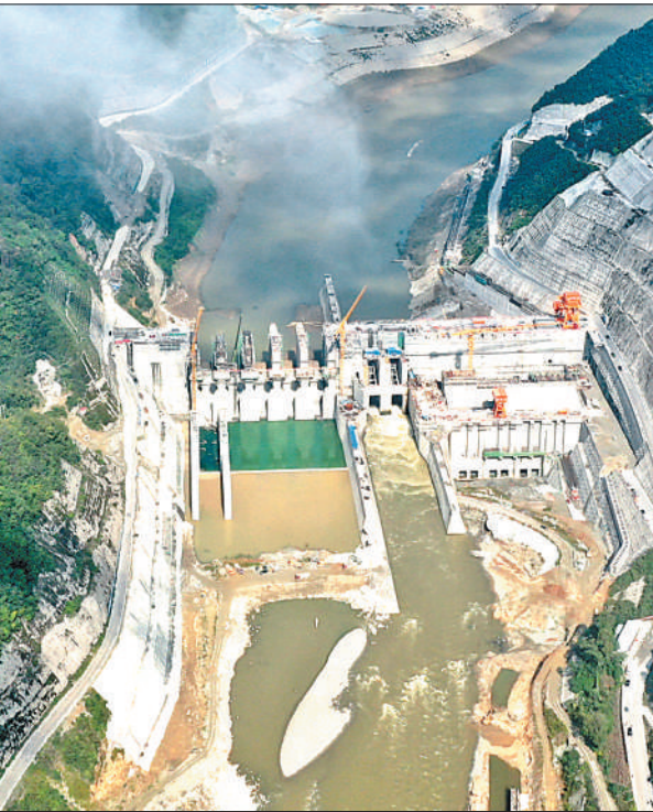
陕西省汉中市引汉济渭三河口水利枢纽建设现场。
