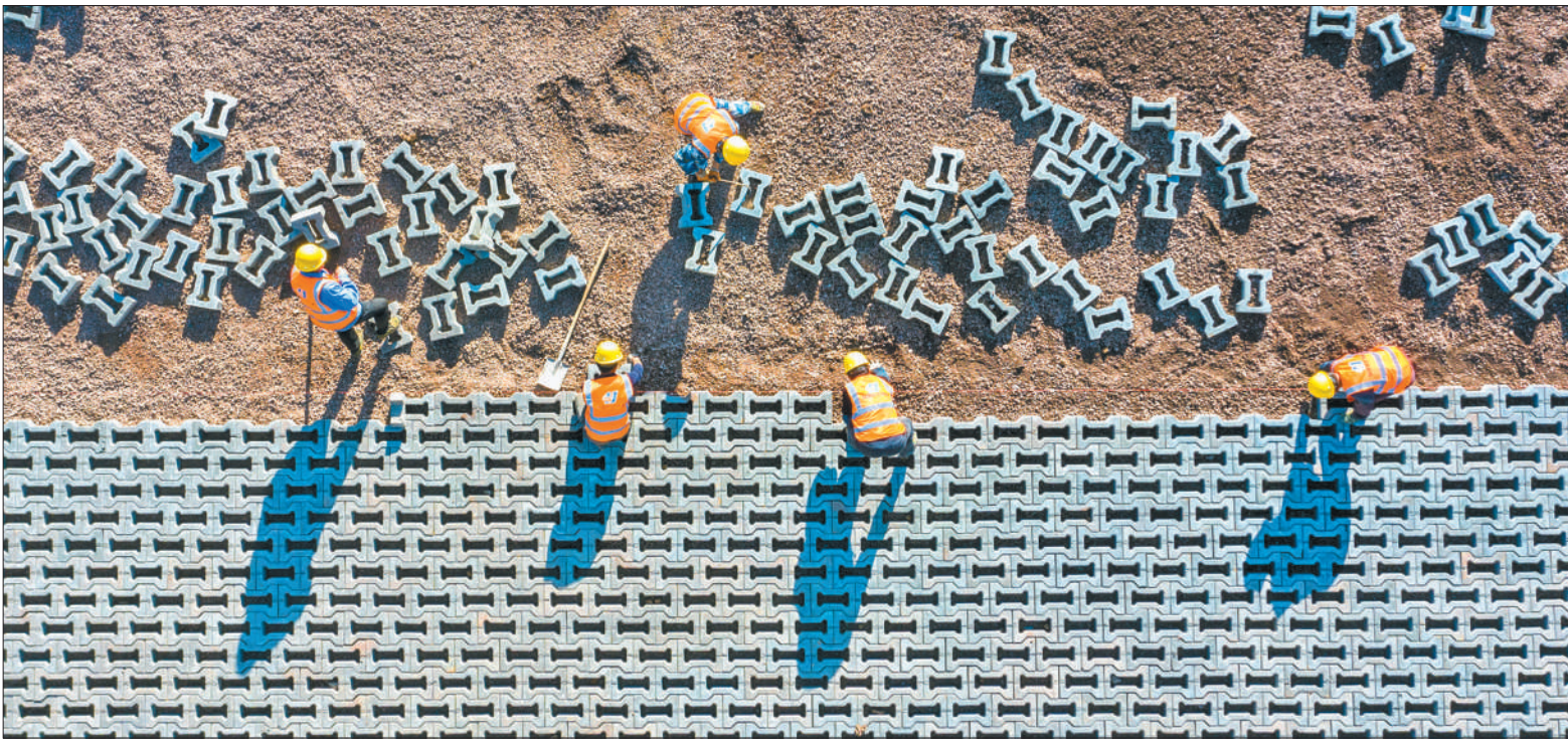
长江安徽省芜湖市河段整治工程现场,工人们正进行生态护坡施工作业。
