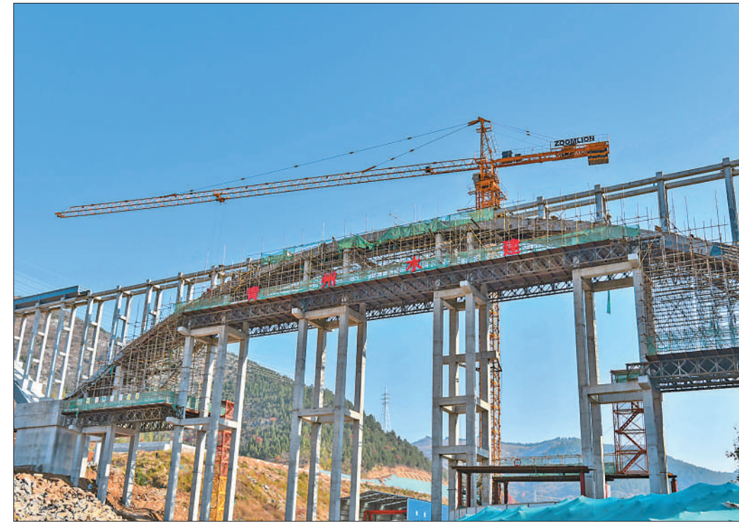
山东省青州市庙子镇,张庄渡槽水利设施加紧施工。
