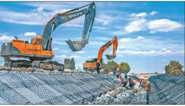
甘肃省张掖市高台县重点水利工程水系连通项目现场,工程建设加快推进。
