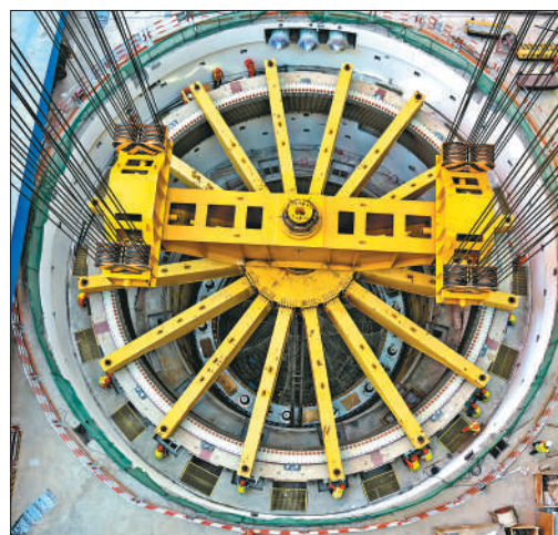
广西壮族自治区大藤峡水利枢纽工程,右岸3号发电机组在进行定子吊装。
