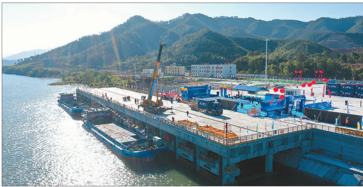
12月18日，在福建南平延平新城港区洋坑码头，满载竹制品、石英砂等货物的“武夷2号”新能源货船鸣笛离港，标志着闽江干流正式恢复通航，拉开了福建省集装箱江海联运的序幕。图为“武夷2号”新能源货船停靠在洋坑码头装运货物。新华社记者 林善传摄
