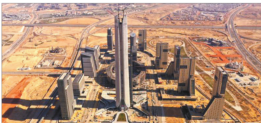
项目。图为建设中的埃及新行政首都中央商务区
