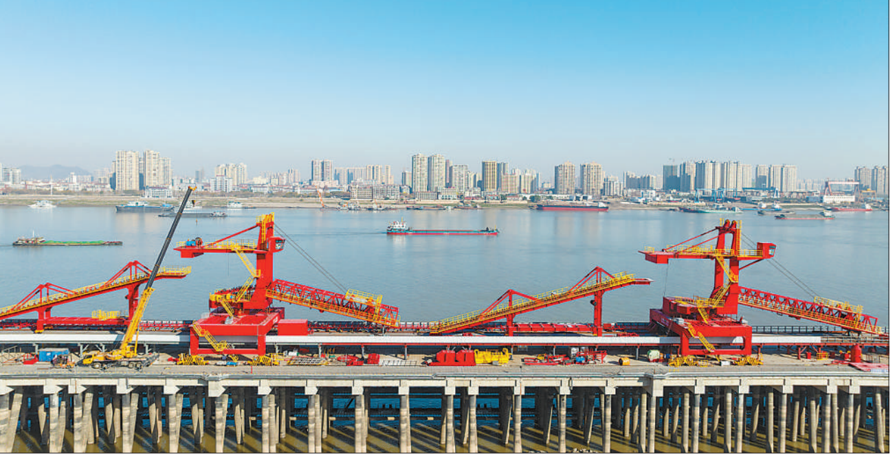
今年以来，各地基础设施建设持续发力，以重大项目为牵引，不断提升运输服务保障能力，促进绿色智慧转型发展。位于江西省瑞昌市的长江金丝港码头项目新建5个5000吨级泊位，设计年吞吐量达3320万吨。项目将建成高效、节能、环保的现代绿色智慧码头，成为通江达海的水陆联运口岸，助力当地经济社会高质量发展。图为12月18日，长江金丝港码头建设工地正在进行设备安装作业。 魏东升摄(影像中国)
