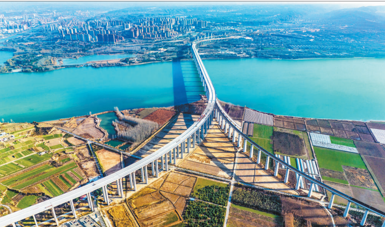
近日,运(山西运城城市)三(河南三门峡市)高速公路三门峡黄河大桥连接线工程全线贯通,标志着运三高速公路全线建成。三门峡黄河大桥连接线,线路全长15.16公里,主线按双向四车道高速公路标准建设,设计时速为80公里。通车后,运城至三门峡车程将在1小时左右,较原先缩短约半小时。
