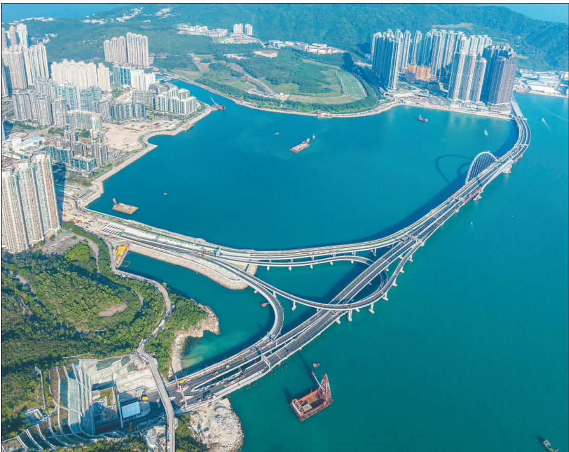
香港将军澳跨湾大桥12月11日正式通车。该大桥为香港新界东南侧湾道的关键跨海通道。桥面宽约35.8米，跨径约200米，跨径最大和单体最重的钢拱桥。图为12月8日拍摄的大桥全貌。严锦文摄(新华社发)
