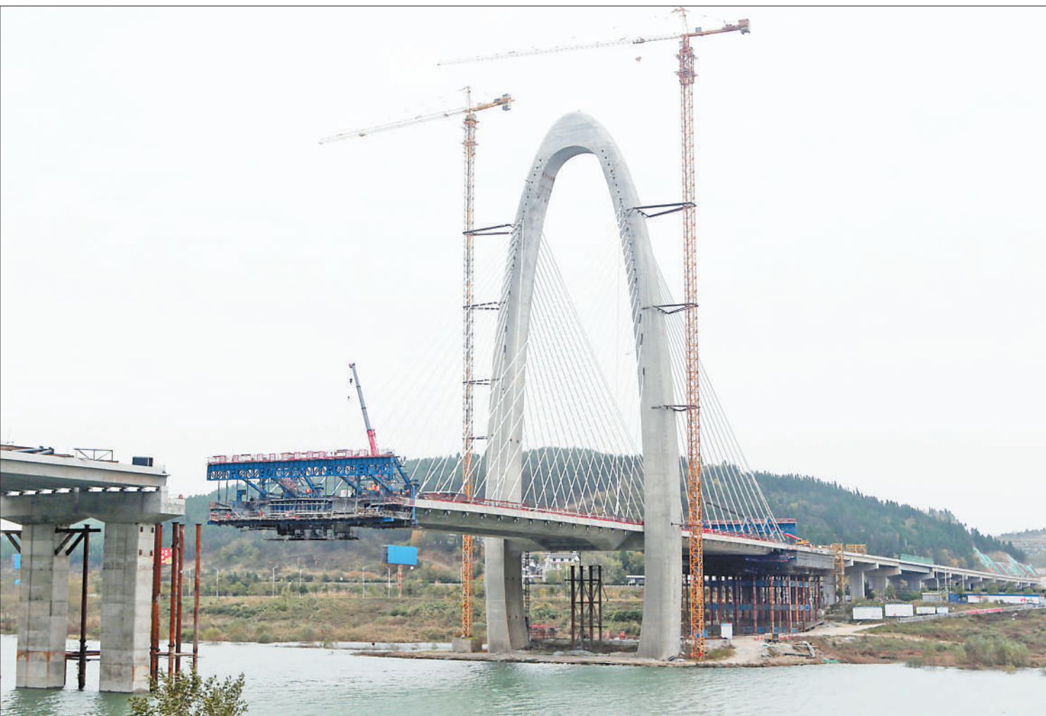
近日,位于四川省广元市的嘉陵江大桥正加紧施工。该桥建成后极大改善当地交通条件,方便居民出行。图为工程建设现场。
