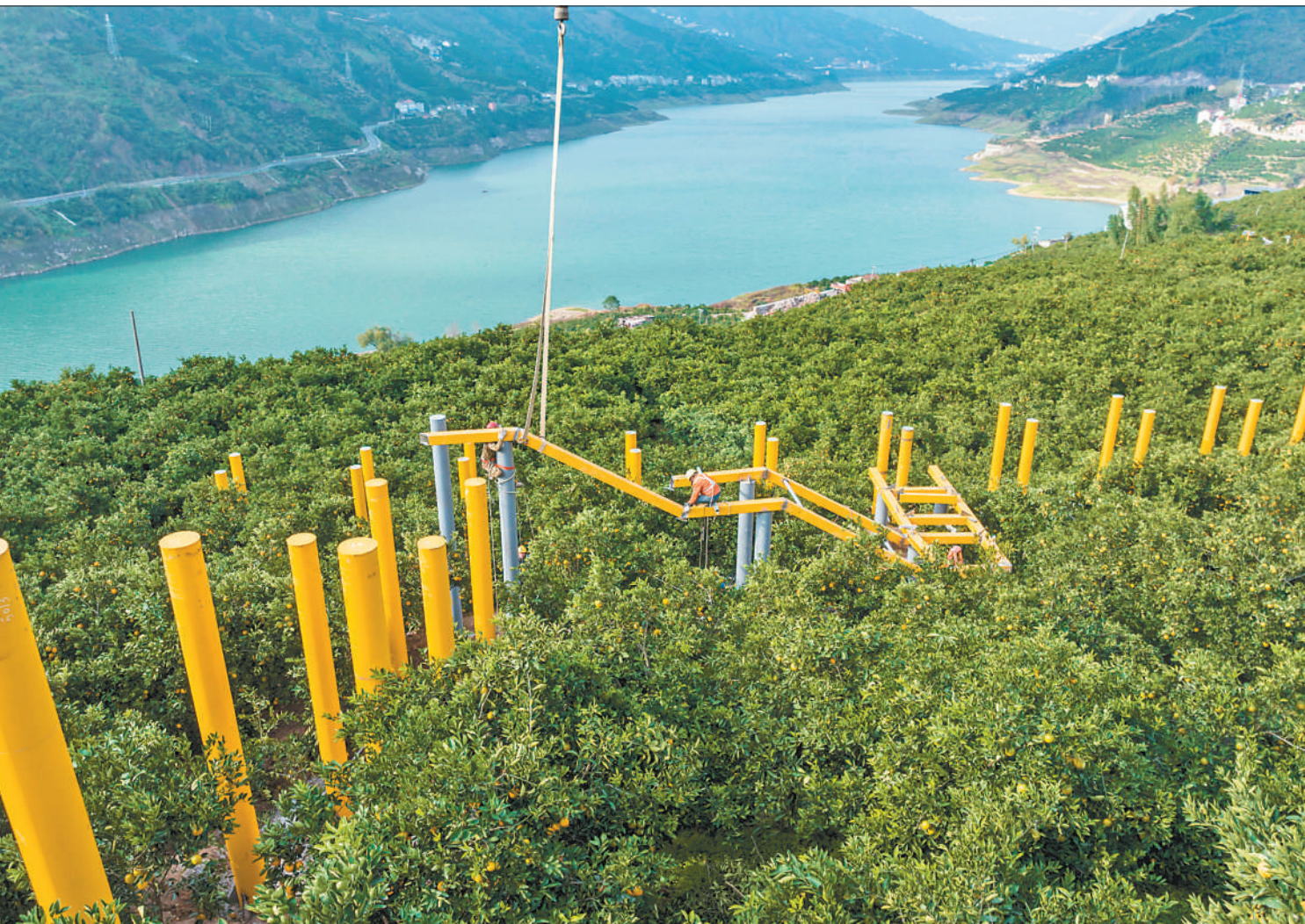
湖北省宜昌市秭归县充分利用自然资源优势,统筹整合资金,加快建设空中观光廊道、脐橙销售中转站等工程,打造高品质脐橙精品果园,助力乡村振兴。图为12月2日,工人在秭归县归州镇彭家坡村脐橙精品果园进行施工。郑家裕摄(影像中国)
