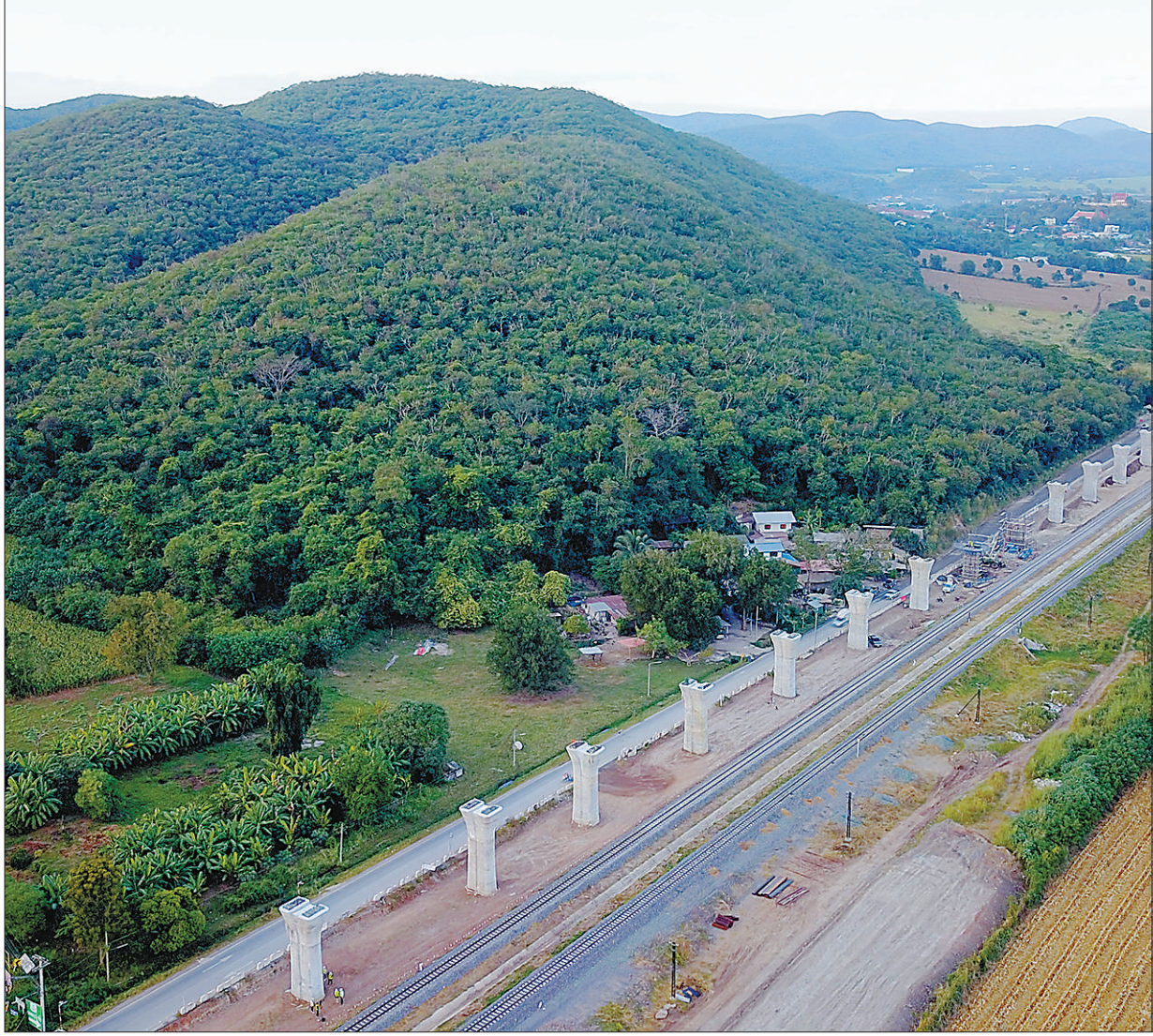
近年来,中泰两国高质量共建“一带一路”成果丰硕,中泰铁路等重大合作项目扎实推进。图为日前在泰国呵叻府拍摄的中泰铁路建设现场。
