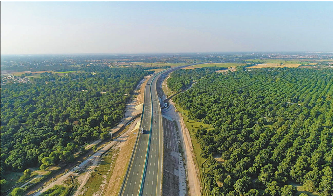
中巴经济走廊框架下最大交通基础设施项目白沙瓦—卡拉奇高速公路苏库尔至木尔坦段由中国建筑股份有限公司(中国建筑)承建。项目打通了巴基斯坦中部南北交通大动脉,显著改善当地交通状况,带动沿线地区经济社会发展。图为苏库尔至木尔坦段高速公路远景。
