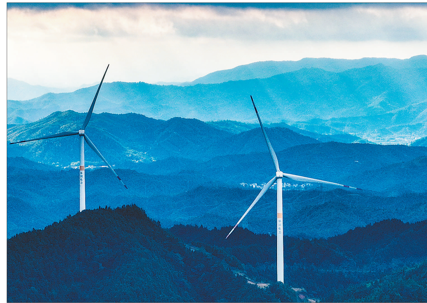
11月28日,在江西省赣州市章贡区沙石镇王田村,绵延起伏的群山间,风力发电机矗立在山脊上,源源不断地输送绿色能源到千家万户。近年来,赣州市积极构建清洁低碳、安全高效的能源体系,大力开发利用风能、太阳能等新能源,有效促进节能降耗、低碳减排。
