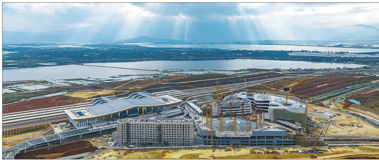
弥(勒)蒙(自)高铁位于云南省红河哈尼族彝族自治州,正线长约107公里,设计开行旅客列车时速目标值为250公里,目前沿线车站建设基本完成。图为近日拍摄的建设中的弥蒙高铁红河站。新华社记者 江文耀摄
