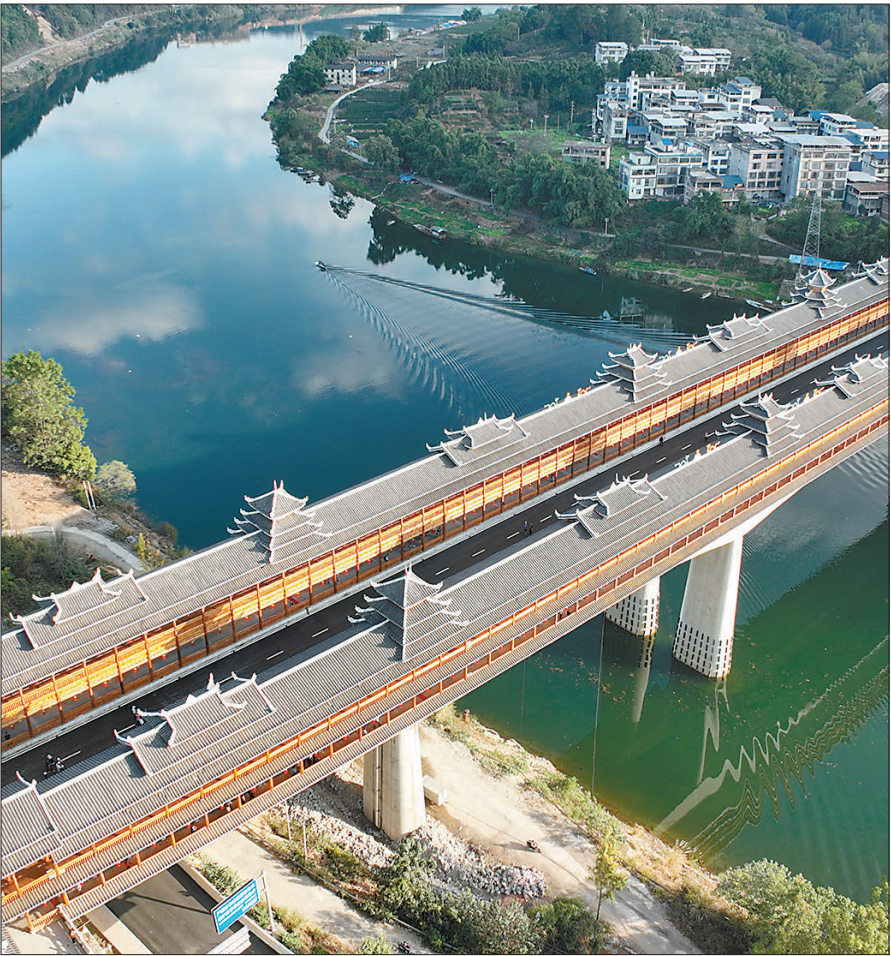
11月28日,广西壮族自治区柳州市三江侗族自治县宜阳风雨桥建成通车。该桥融合侗族风雨桥特色造型元素及现代建筑风格,通车后不仅让附近居民出行更加方便,也成为一处新景观。图为宜阳风雨桥。
