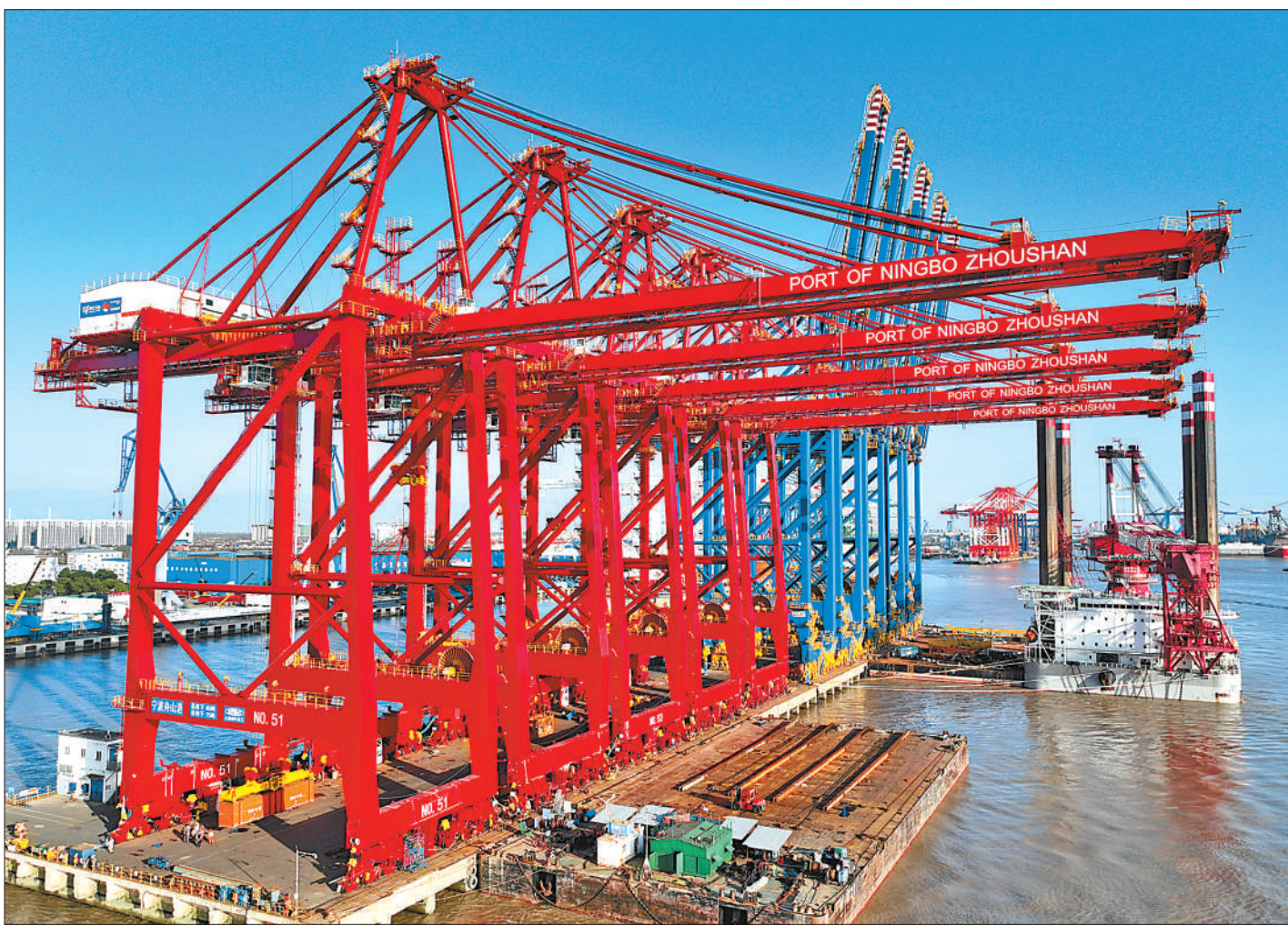
近年来,上海振华重工加大自主研发投入力度,深入研究机械结构、驱动、控制三大系统。据了解,振华重工产品已进入一百多个国家和地区。图为十一月二十三日拍摄的准备发往国内外的岸桥设备。许丛军摄(人民视觉)
