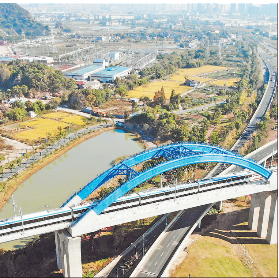
近日,浙江省台州市域铁路S1线的试跑列车在当地路桥区路桥北街道路段经过。台州市域铁路S1线一期工程是采用政府和社会资本合作(PPP)模式的市域铁路项目,将于年底前开通运营。 蒋友青摄(影像中国)
