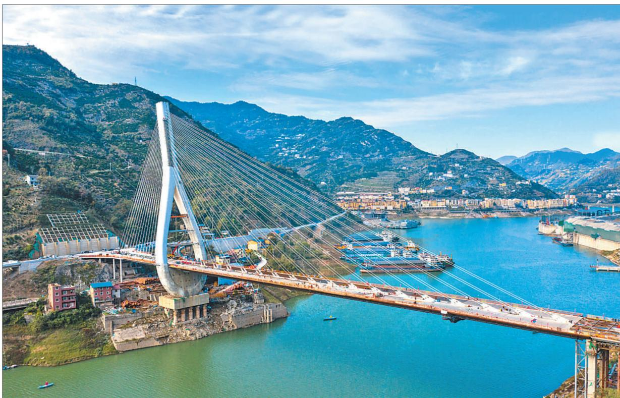
近日,湖北省宜昌市的香溪河大桥正在抓紧建设,琵琶形独塔斜拉桥的主体结构已经成形。香溪河大桥是连接宜昌市兴山县峡口镇和秭归县乐平里区域的重点交通枢纽工程,塔身采用顺桥向倾斜10度的琵琶造型。项目预计2023年建成通车。图为建设中的香溪河大桥。 郑 坤摄(影像中国)
