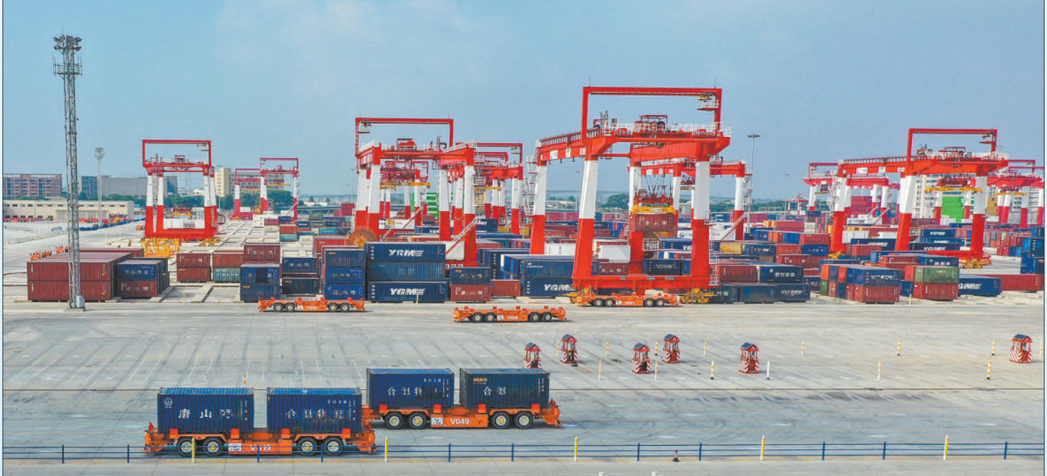
广东省广州港南沙港区四期全自动化码头正式投入运行。该码头是全球首个江海铁多式联运全自动化码头,集北斗导航、5G通信等技术于一体,创造了60多项专利,其中发明专利31项。 刘 伟 摄(影像中国)
