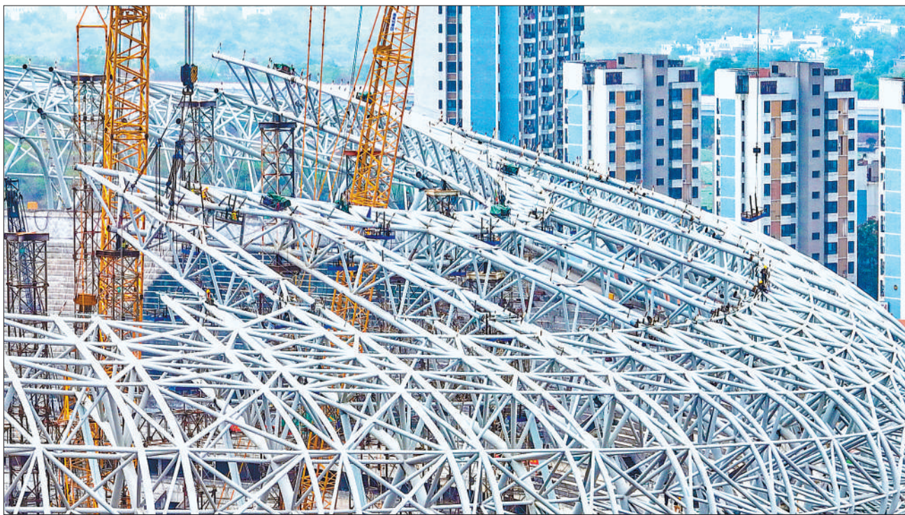
11月18日,江西省赣州市全民健身中心综合体育场项目建设现场,施工正在进行。项目建成后,将为市民提供更加优质的健身环境。 胡江涛摄(人民视觉)
