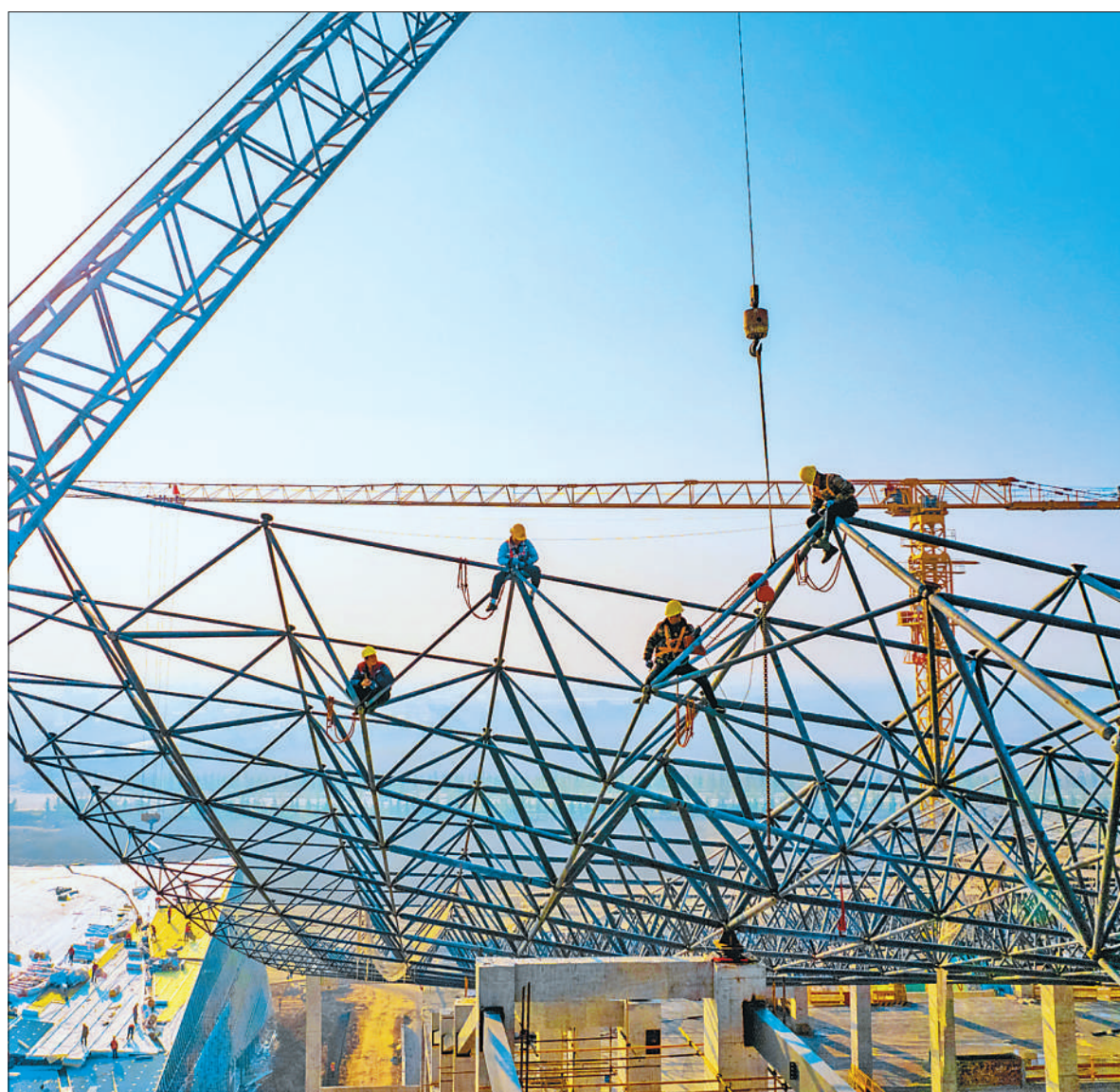
11月16日，山西省运城会展中心项目建设现场，工人在架设展馆钢结构，全力推进展馆建设及配套工程施工。常奇摄（影像中国）
