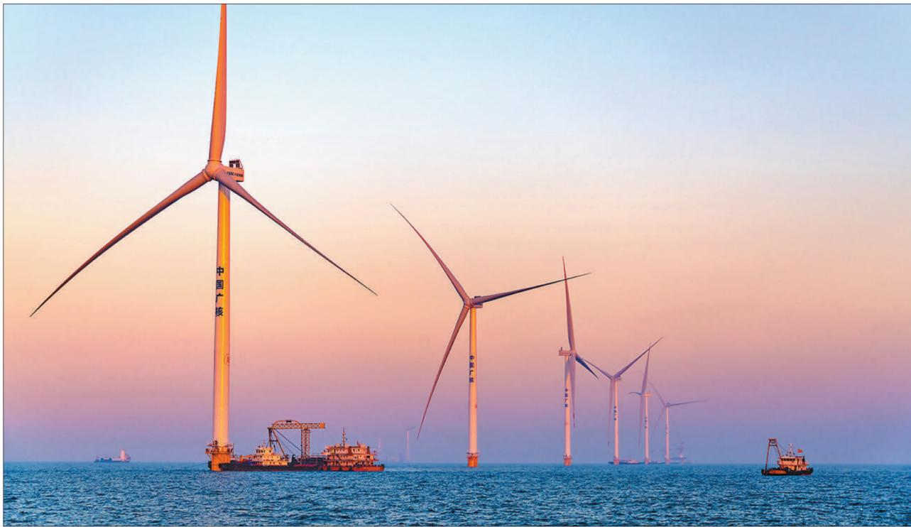
11月15日，山东烟台莱州湾中广核莱州海上风电项目现场，作业船正在8号风机处进行海底电缆敷设。
