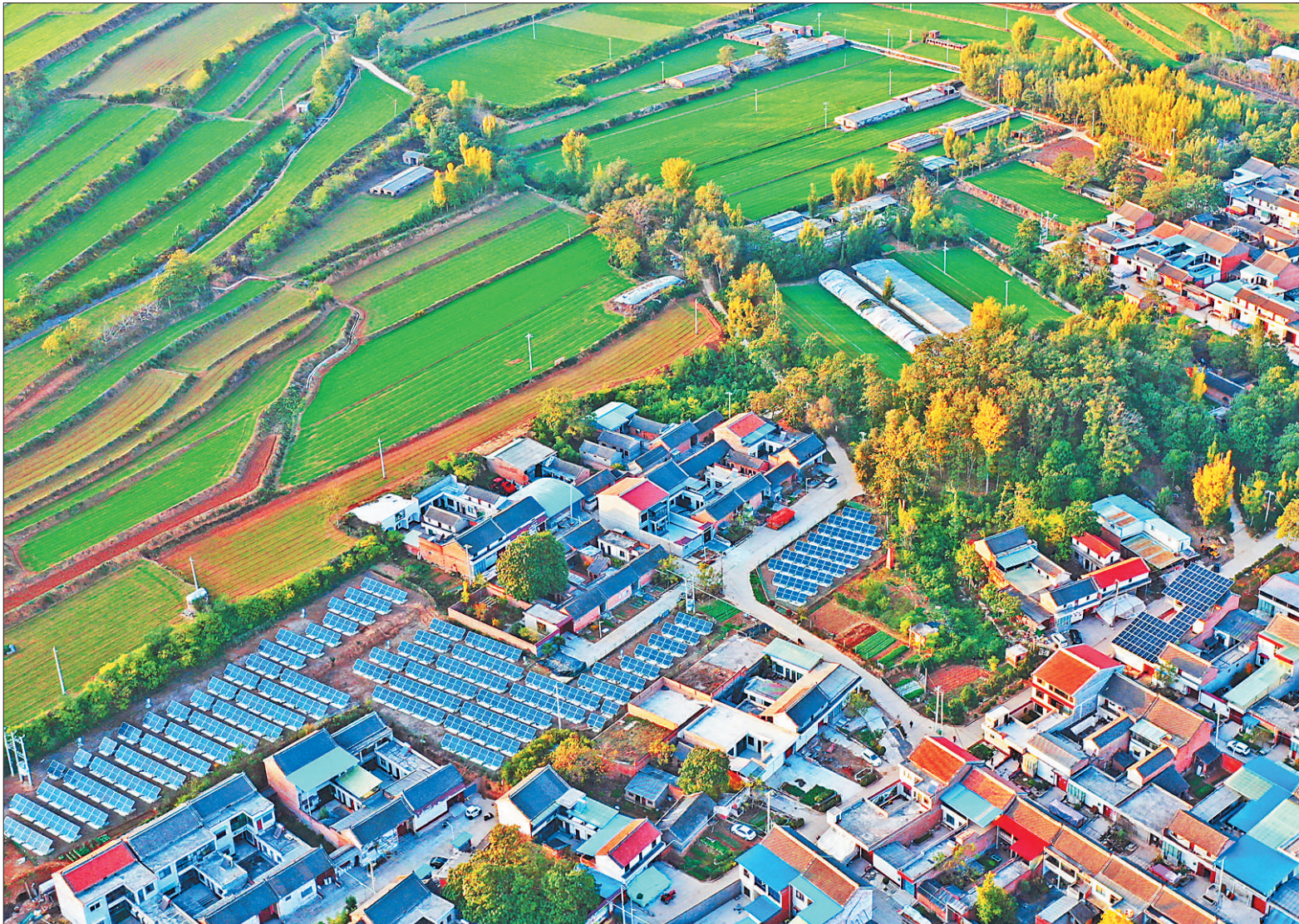
11月13日，河南孟州市赵和镇下坡村的光伏发电项目成为村里一道风景。近年来，孟州市大力发展清洁能源，鼓励群众利用房屋屋顶、扶贫基地、企业厂房等建设光伏发电项目，助力乡村振兴。
