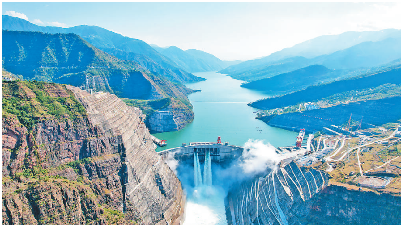
11月5日,白鹤滩水电站10号机组正式投入商业运行,这是该水电站投产发电的第十五台百万千瓦水轮发电机组。目前,水电站进入全面投产发电的最后冲刺阶段。 闫科任摄(影像中国)
