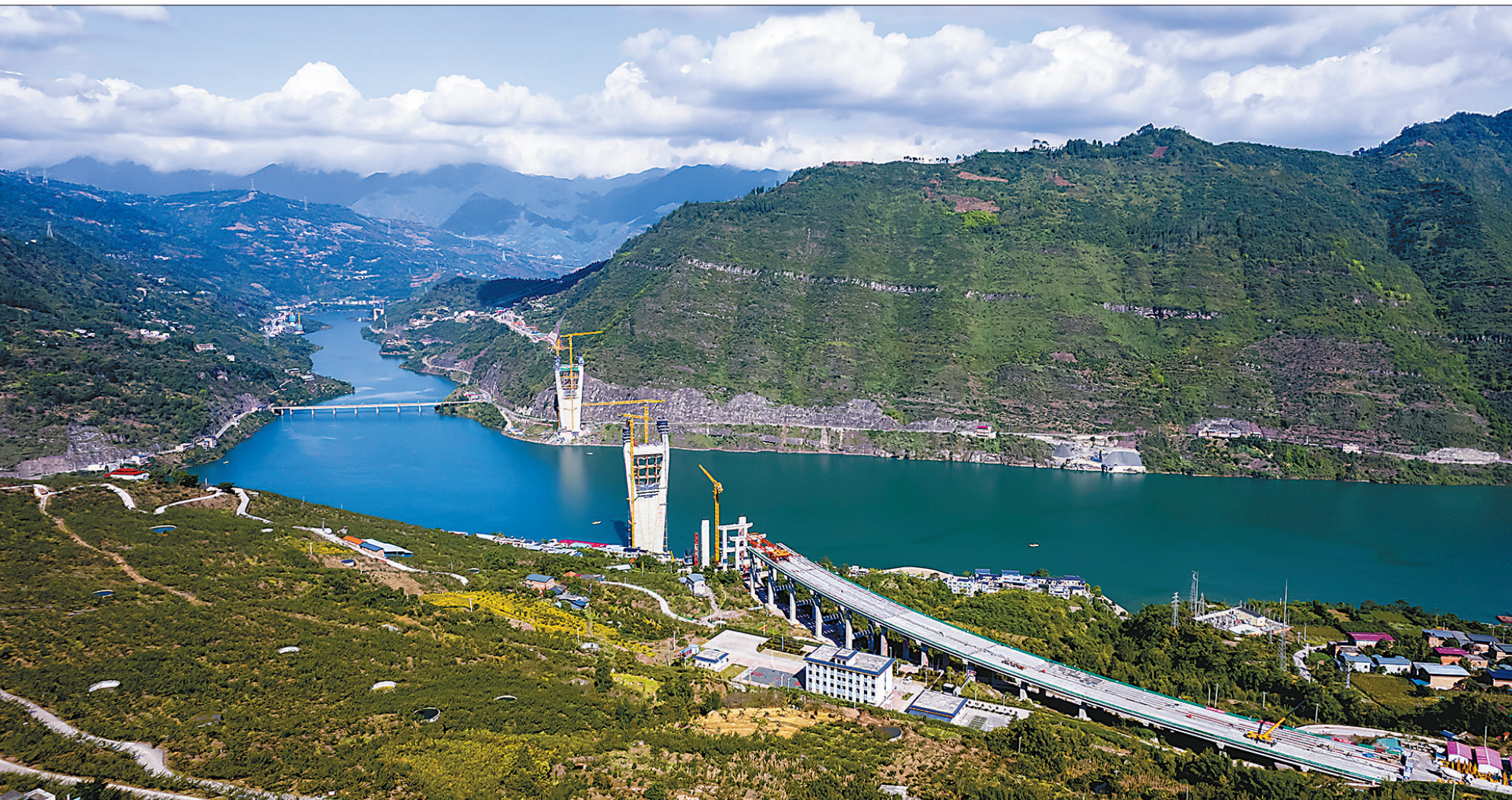
10月30日,建设中的新市金沙江特大桥施工现场。新市金沙江特大桥横跨金沙江,连接四川省宜宾市屏山县新市镇和云南省昭通市绥江县南岸镇,对畅通川滇两地交通、促进经济社会发展具有重要意义。
