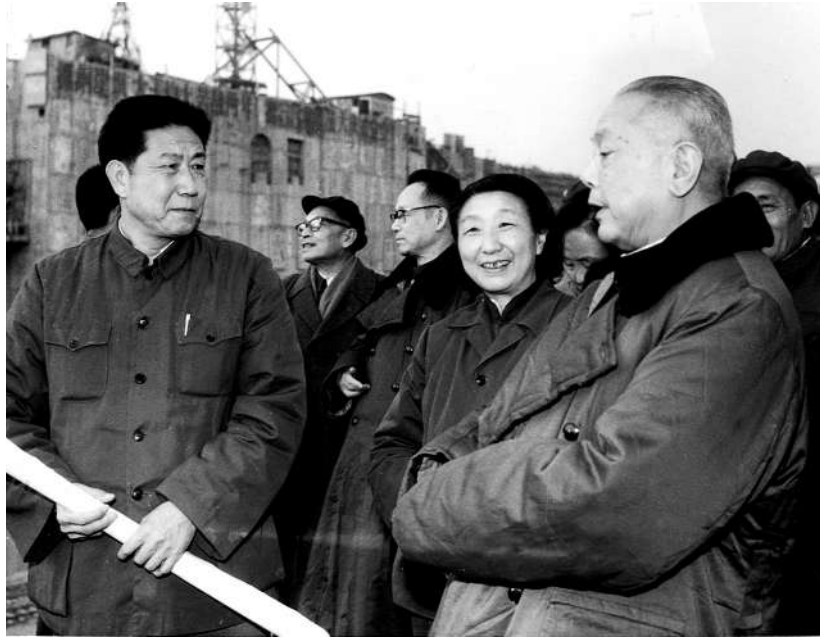
1978年1月，钱正英同志(前右二)陪同李先念同志和谷牧同志视察长江葛洲坝工程建设。 新华社发
