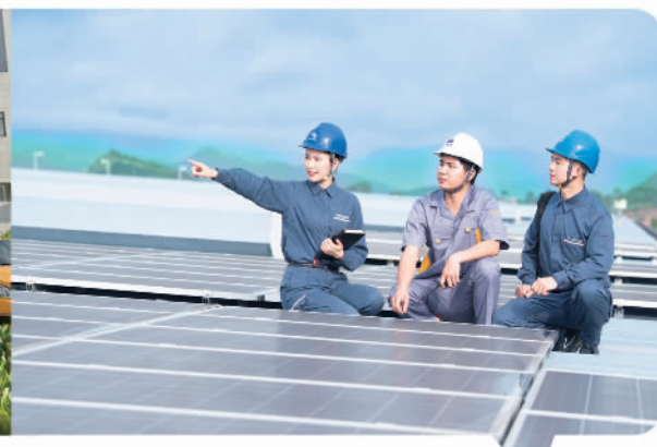
南方电网广西桂林供电局组织专家开展屋顶光伏安全用电服务
