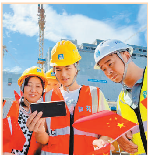
广东省佛山市和祐医院项目施工现场,工人们在手机上观看党的二十大开幕会。
