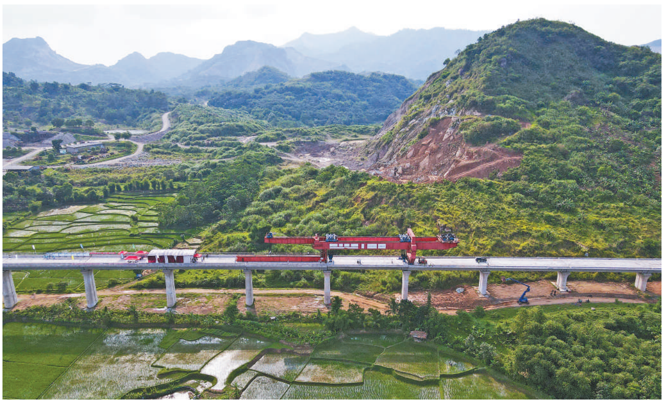
10月16日，印度尼西亚雅万高铁全线箱梁架设任务顺利完成，铺轨通道全面打通。图为当天在印度尼西亚西爪哇省哇达基拍摄的雅万高铁全线最后一根梁架架施工现场。雅万高铁全长142公里，是共建“一带一路”倡议和中印尼两国务实合作的标志性项目。新华社记者 徐 钦 摄
