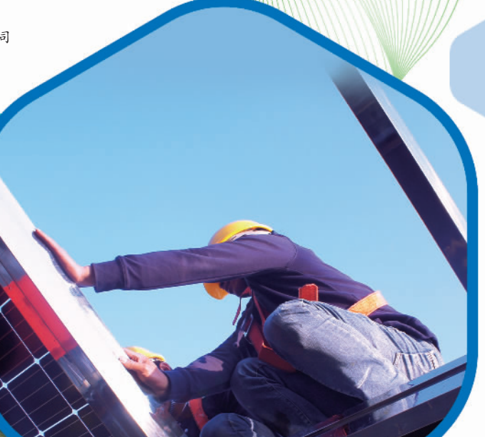
光伏电站安装施工
