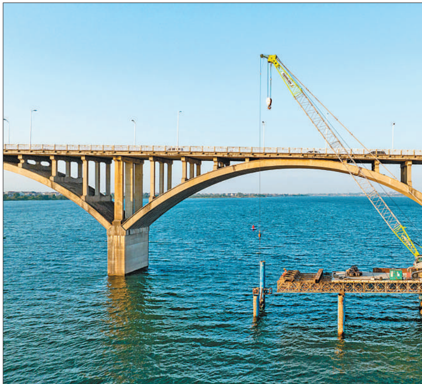
图①：江西省新干县S312赣江大桥改造工程现场，施工方正在搭建左幅新建桥梁钢栈桥。
