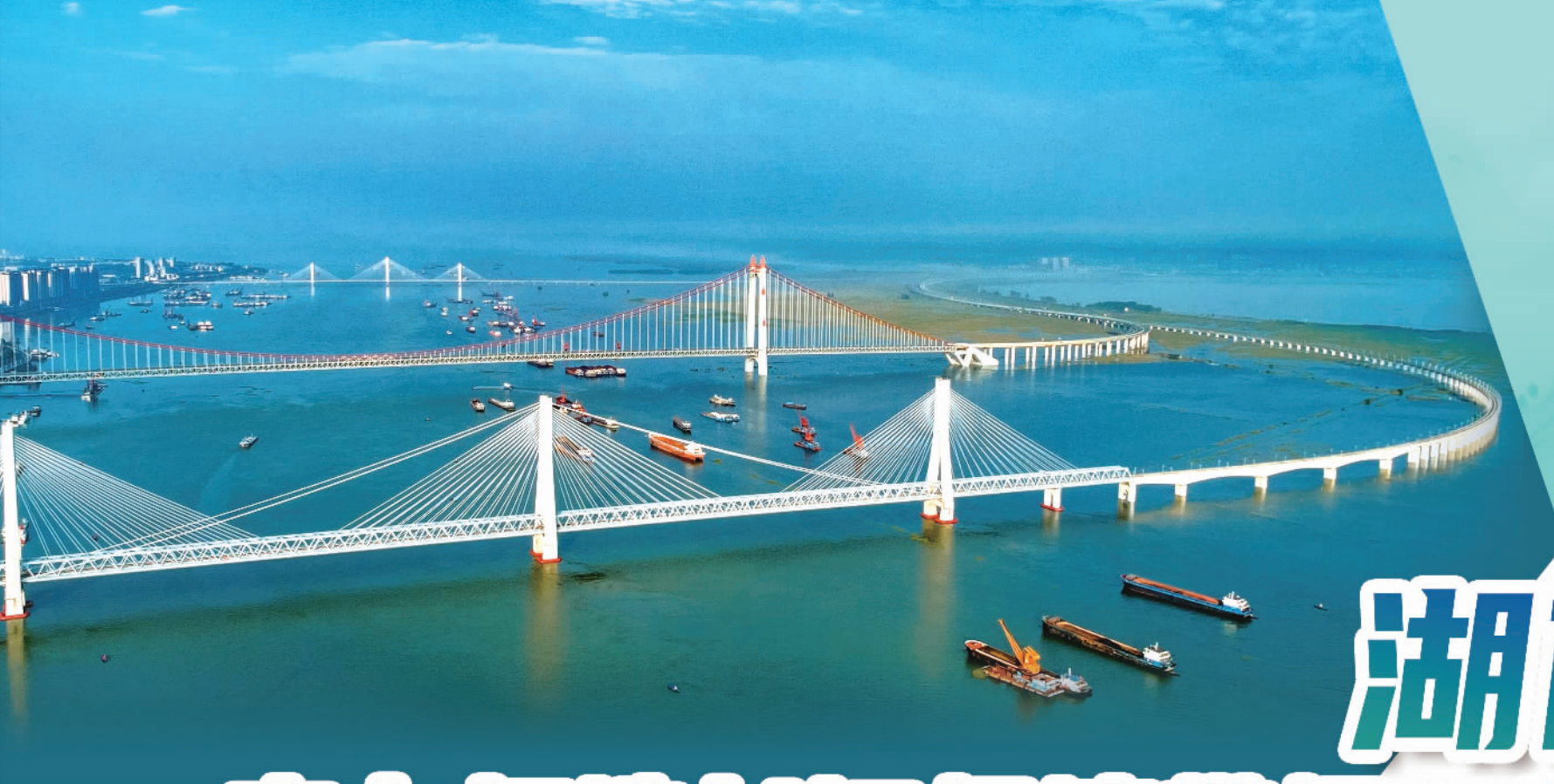
跨越洞庭湖三座大桥
