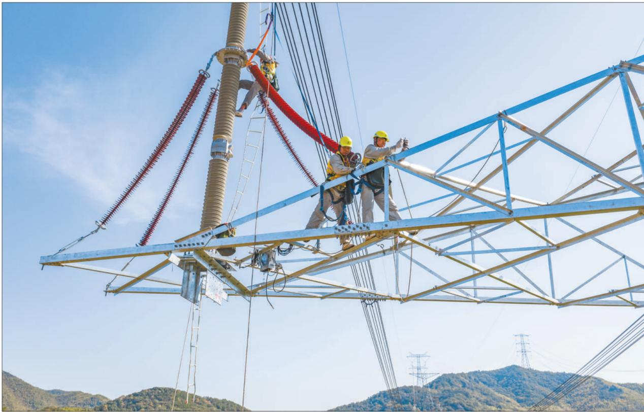
10月10日,在安徽省芜湖市繁昌区孙村镇境内的吉泉线特高压输电塔上,电力工人正在安装避雷器。
