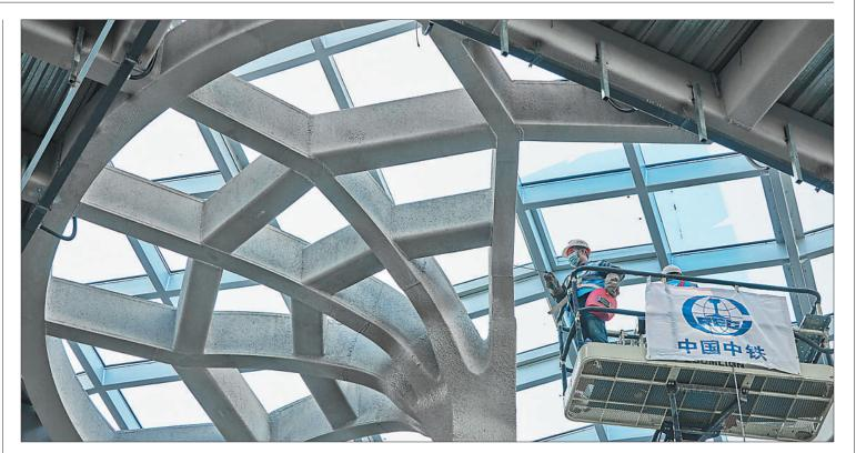
10月4日,北京通州城市副中心图书馆,工人在顶部进行焊接。中铁建工集团第一建设公司城市副中心图书馆工程当前进入装饰装修阶段 本报记者 张武军摄
