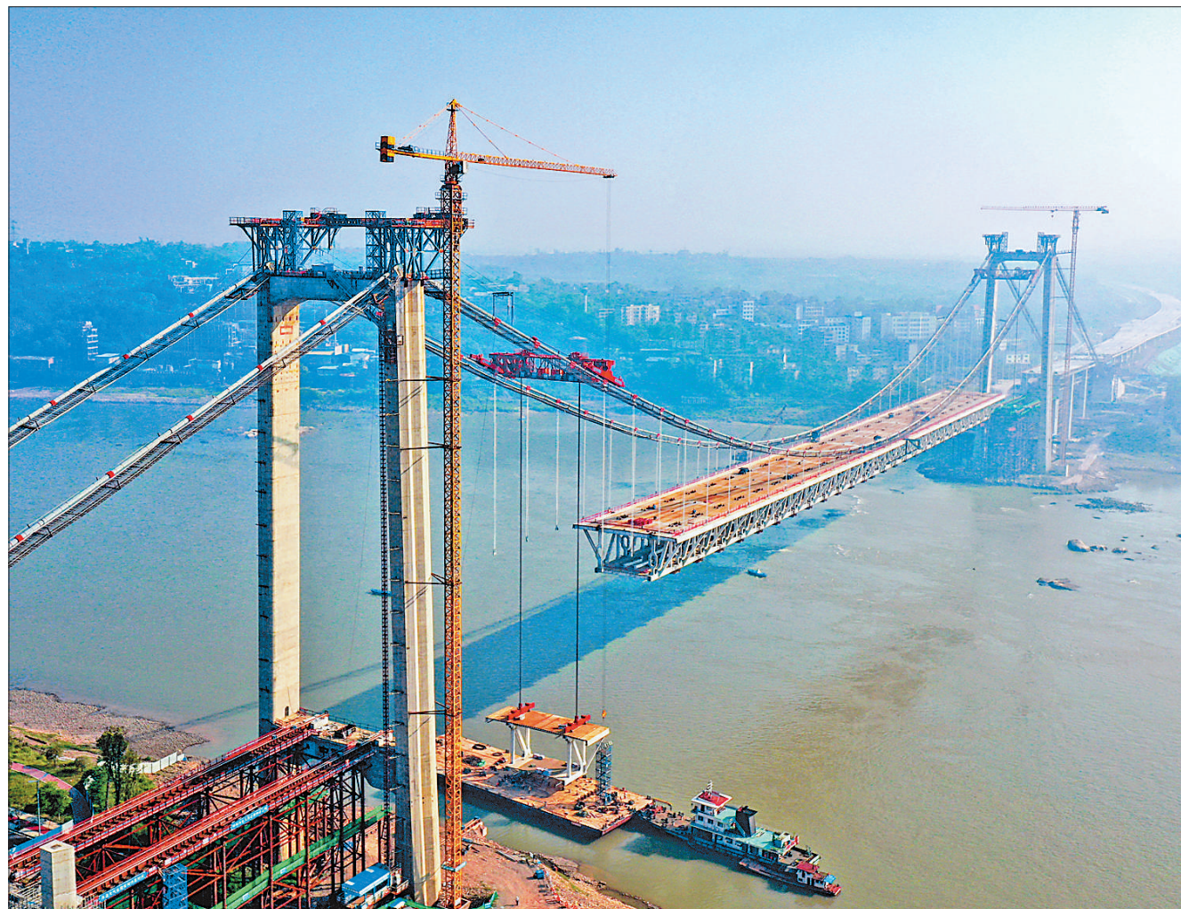
10月3日,四川省泸州市长江二桥建设现场,工人们在抓紧实施钢桁梁吊装作业。
