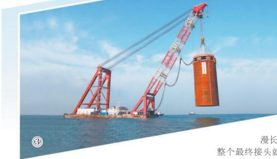
37.95米、高11.4米的节段管节，通过60束预应力钢绞线的张拉，像穿糖葫芦似的连在一起。这就是建桥工程师们口中常说的“绣花活”。
