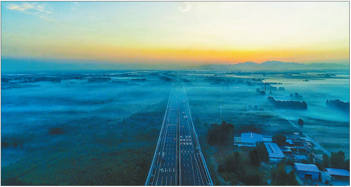
近年来，山东以建设交通强国山东示范区为契机，着力优化综合立体交通网。山东高速集团投资建设的济南至青岛高速公路改扩建项目，成为全国高速公路改扩建绿色科技示范工程，加速了山东省会城市经济圈与半岛蓝色经济区的融合发展，为山东实现海陆运输快速衔接提供了支撑。图为济南至青岛高速公路章丘段。
