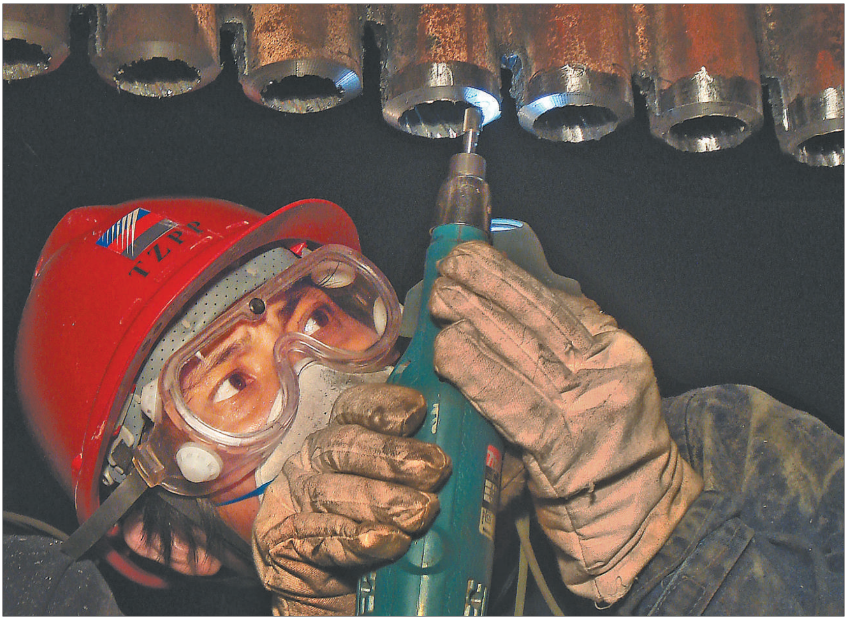
近日,在浙江省台州市椒江区,当地发电厂电力工人正在进行锅炉管道检修工作,保障设备正常运行。 窦瀚洋 徐新勇 摄影报道
