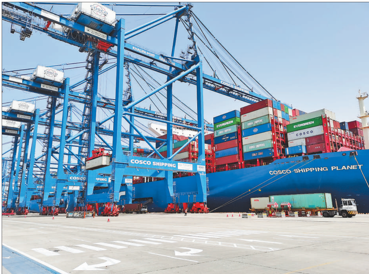
今年1月至8月，中远海运港口阿联酋阿布扎比码头(哈里发港二期集装箱码头)已完成集装箱吞吐量58.9万标准箱，同比增长34%，累计操作2000艘次船舶。图为近日，可装载2.1万个标准集装箱的“中远海运行星”轮正在阿布扎比码头作业。
