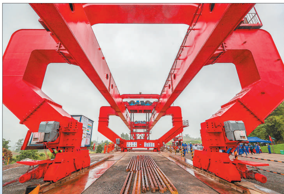
图①:四川宜宾临港公铁两用长江大桥项目建设现场,工人正在进行跨梁段钢箱梁吊装。这座大桥是渝昆高铁、蓉昆高铁的共同过江通道。 王宇摄(影像中国)
