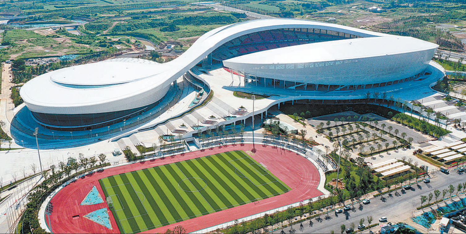
场馆建设稳步推进
