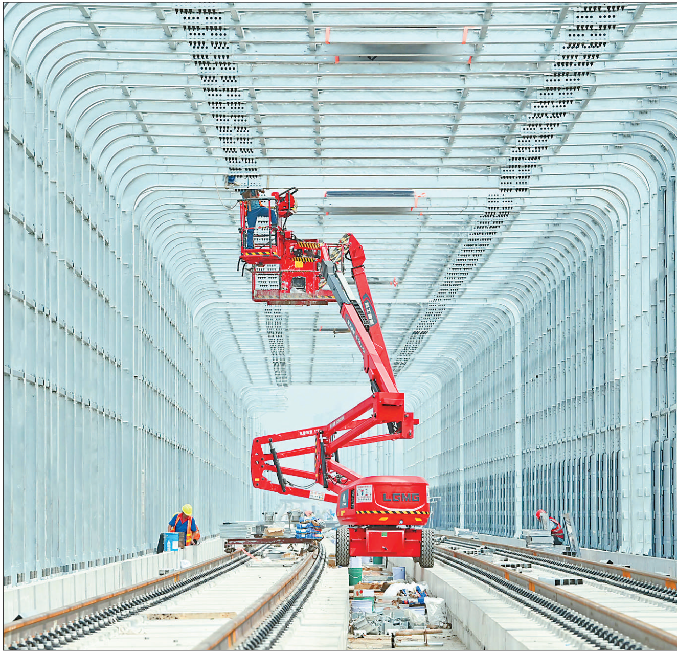
9月10日，安徽省滁州市南谗区腰铺镇，建设者们正在滁(滁州)宁(南京)城际铁路二期高架线上安装环保声屏障。中秋假期，中铁四局500余名铁路建设者坚守岗位，推进建设，确保进度。宋卫摄(影像中国)
