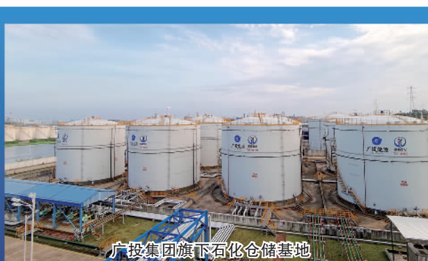
广投集团旗下石化仓储基地
