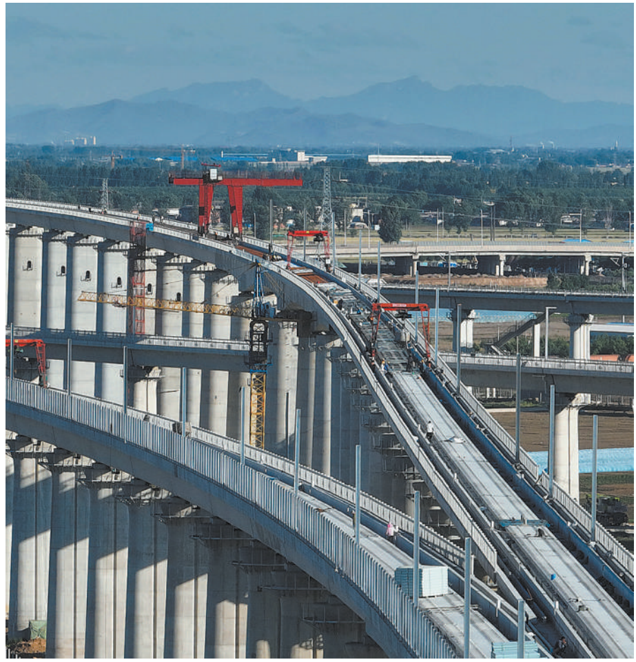
图为京唐城际铁路建设现场。
